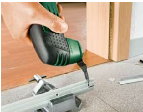
Vloerprofiel aanpassen.
