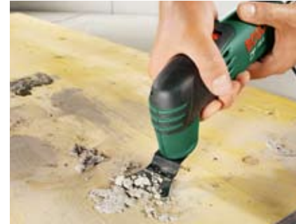
Betonresten verwijderen.
