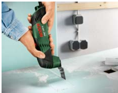
Gipskartonplaat uitzagen.
